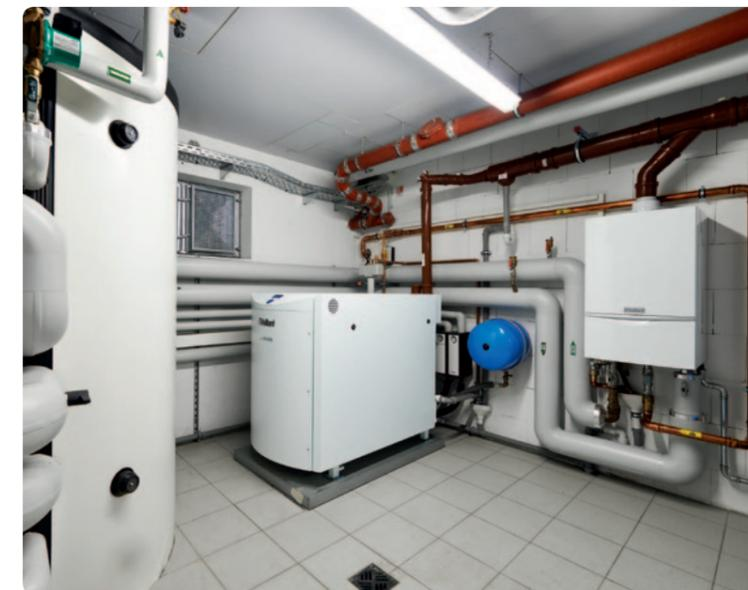
Das Kraftwerk im Heizungskeller: mini-BHKW ecoPOWER 4.7
