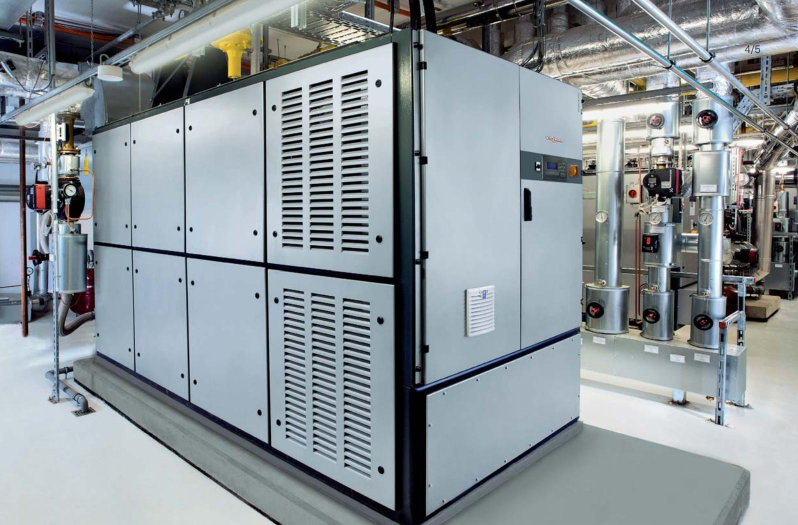
Blockheizkraftwerke von Viessmann erreichen einen Gesamtwirkungsgrad von bis zu 95 Prozent. Zusammen mit der gleichzeitigen Erzeugung von Strom und Wärme sind BHKWs damit äußerst effizient.
