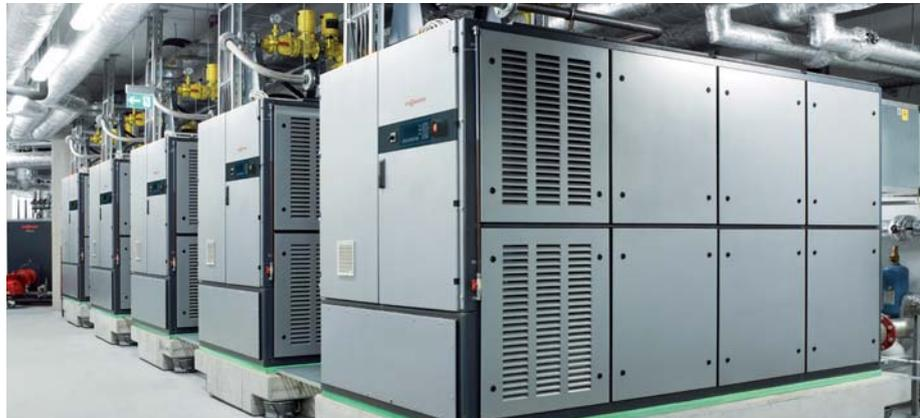
Fünf Vitobloc 200 Blockheizkraftwerke im Verwaltungsgebäude der Deutschen Gesetzlichen Unfallversicherung
